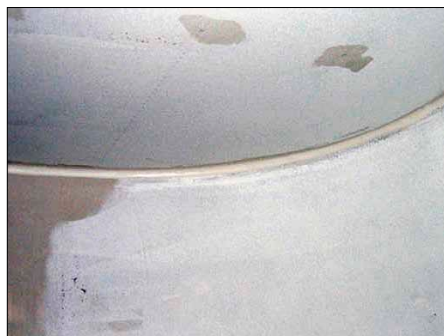
FUGING MOT HIMLING: For å unngå oppsprekking mot himlingen fuges det med malerakryl. En jevn liten bue her gjør også at overgangen til himlingen blir mindre synlig. (Foto: Svein Sando)
